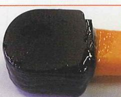
③端末処理ケースに2液混合したシーリング材を注入します。
