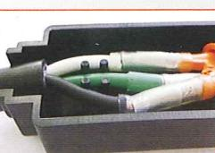
②ヒーターと電源コードの3本の線を、油密端子と収縮チューブを用いて接続し、電源コード接続ケースに入れます。
